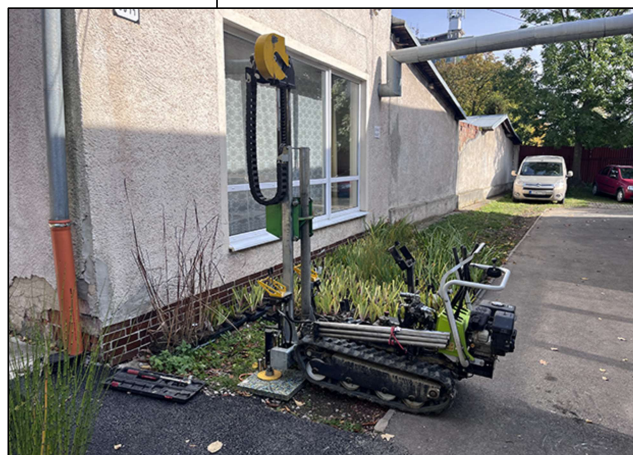
Foto 01: Dynamická penetračná sonda DP-3
