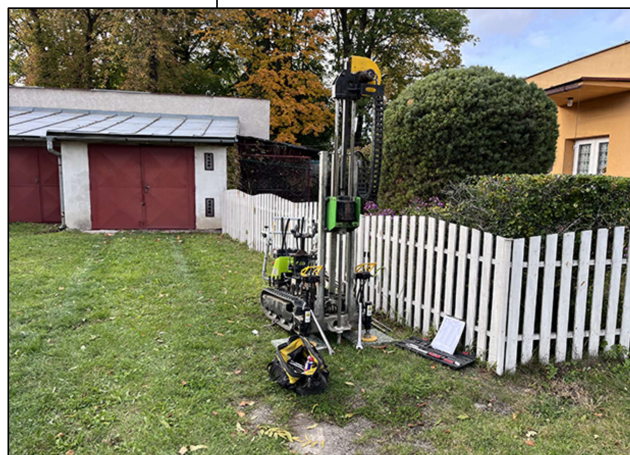
Foto 01: Dynamická penetračná sonda DP-1
