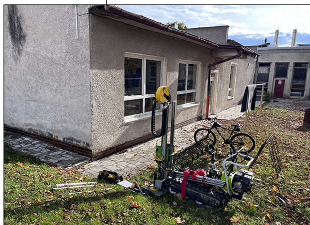
Foto 01: Dynamická penetračná sonda DP-4
