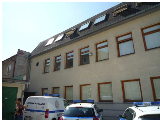
Pohľad na ľavé (východné) krídlo budovy
