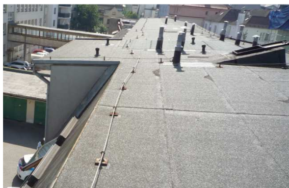
Pohľad na vysunutú časť strechy nad sociálnymi zariadeniami a pohľad na výlez na strechu
