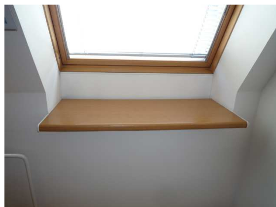
Typický pohľad z interiéru na strešné okno. Bez nedostatkov.
