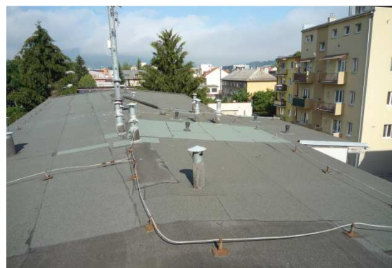
Pohľad na strechu pravého krídla; južná časť
