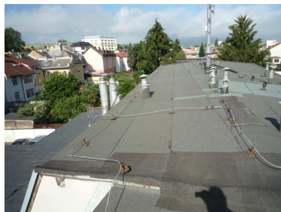
Pohľad na strechu pravého krídla; južná časť
