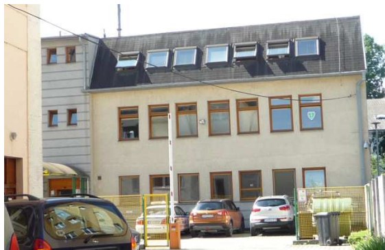
Pohľad na pravé (západné) krídlo a vstup do budovy MšP
