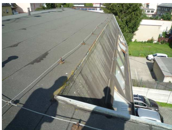
Pohľad na styk vysunutej strechy nad soc. zariadeniami, strmou strechou a nízkou strechou
