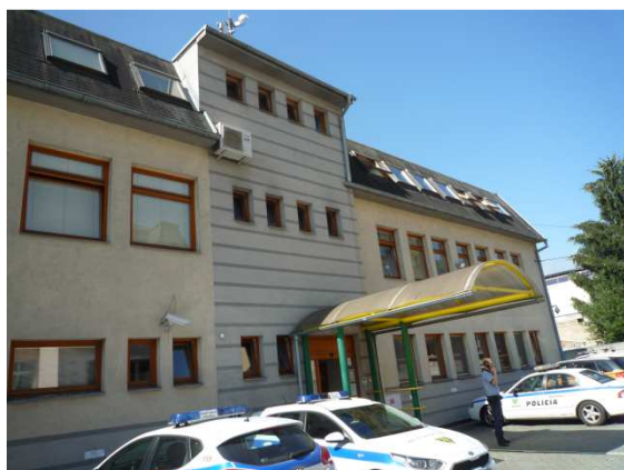
Pohľad na vstup a pravé krídlo budovy
