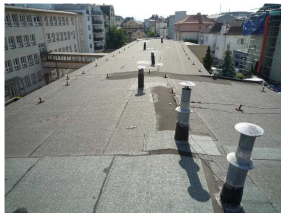
Pohľad na strechu ľavého (východného) krídla objektu
