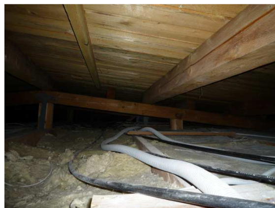
Typický pohľad do podstrešného priestoru
