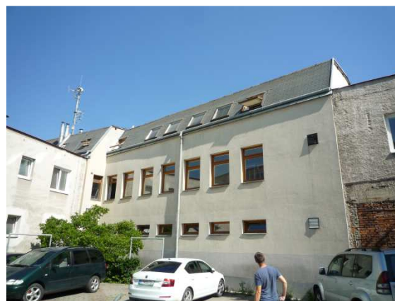
Zadný pohľad na ľavé krídlo budovy
